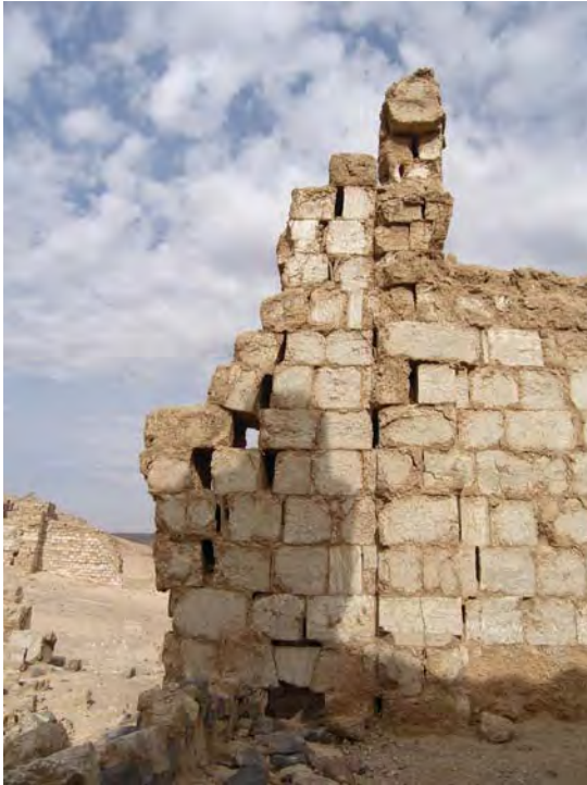
Fig. 9: Mur de l'église du Nord-Ouest avant consolidation
