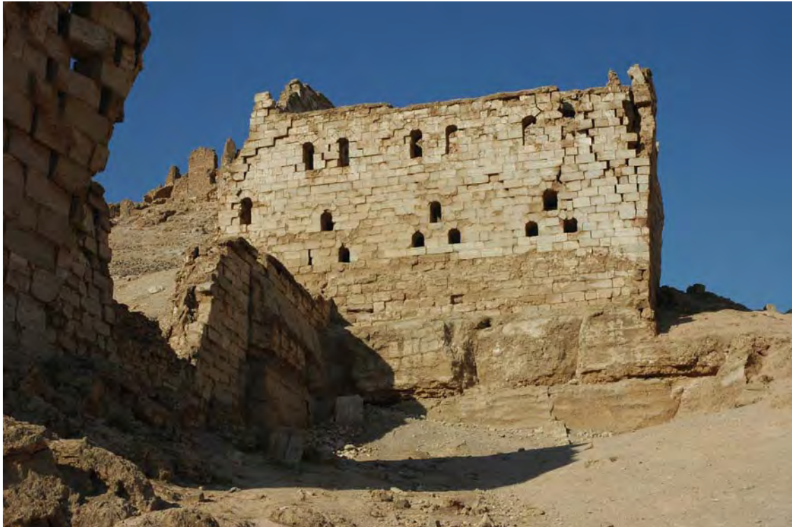
Fig. 11: Vue du prétorium de puis l'extérieur des remparts. Face Est
