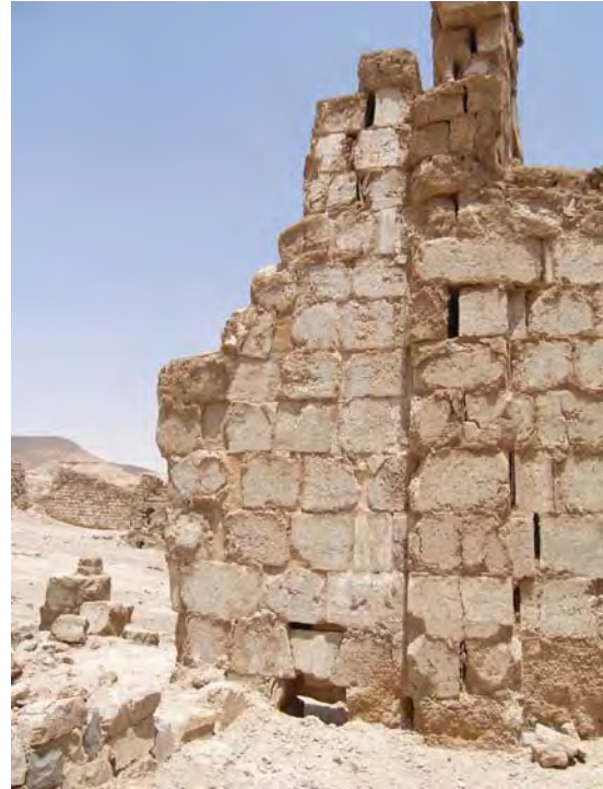
Fig.10: Vue du même mur de l'église du Nord-Ouest après restauration
