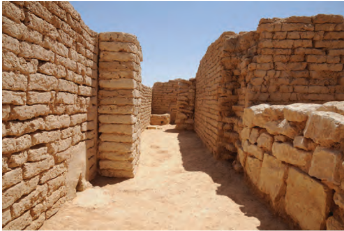
Fig. 3: Vue du couloir dans l'angle nord-est du bâtiment E (photo Denis Genequand).
