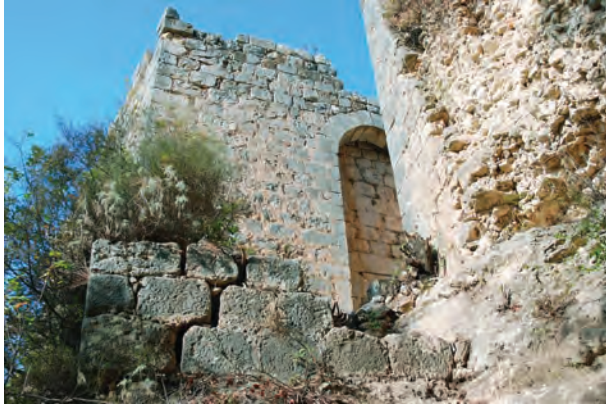
Fig. 10: Vue de la tour-porte sud depuis l'est.
