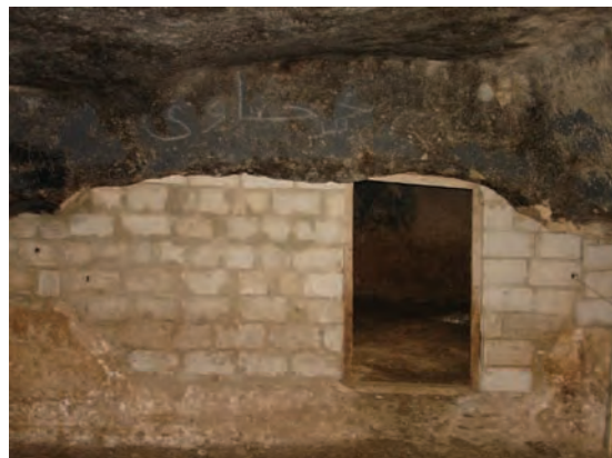
Fig. 10 : Wadi el-Rhban : Habitat A - Salle II - La paroi septentrionale.
