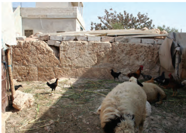
Fig. 8: rempart de la ville byzantine conservé à l'intérieur des maisons.
